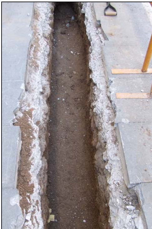
Fotografia núm. 2: vista de la rasa 100.
