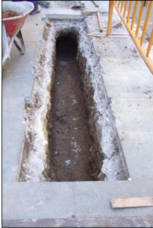
Fotografia núm. 1: Vista de la rasa 100.
