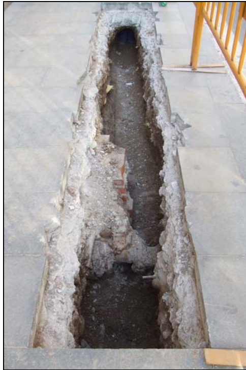
Fotografia núm. 3: vista de la rasa 100.
